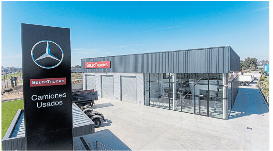
SOBRIEDAD. Chapa negra en cenefas, chapa sinusoidal galvanizada en paredes y cerramientos negros.
